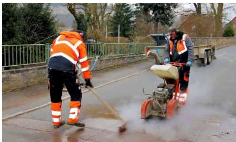
Daniel Müller (r.) und Frank Degen von der Naumburger Firma EWG Müller schneiden zunächst die Asphaltsschicht des schadhaften Bereichs auf.
