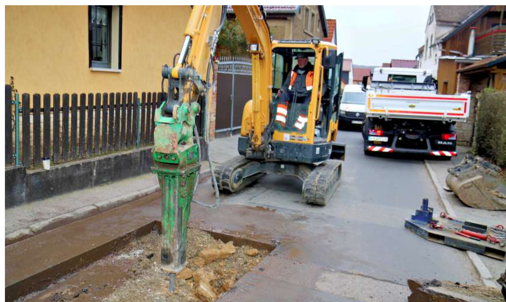
Daniel Müller steuert den Bagger, um die 30 Zentimeter dicke Betonschicht in der Thüringer Straße aufzubrechen.
